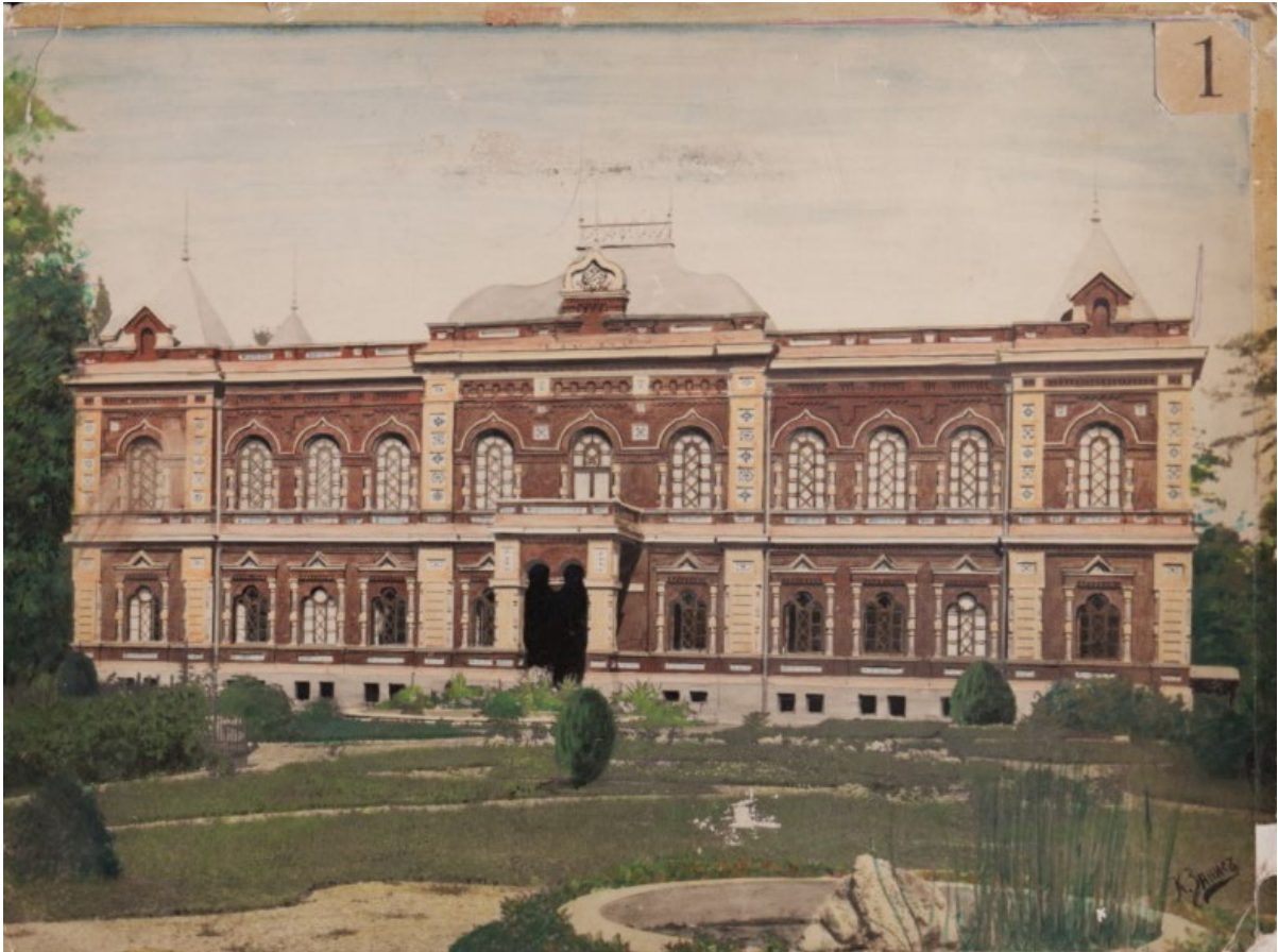
SP1001. Bâtiment principal de la Station séricicole du Caucase: façade avant (retouchée). Tbilissi, Géorgie. 1892. Photo de Konstantin Zanis.
